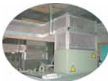
5 – Montáž krycích stěn
