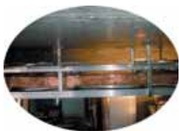
4 – Sestavení konstrukce krytů
