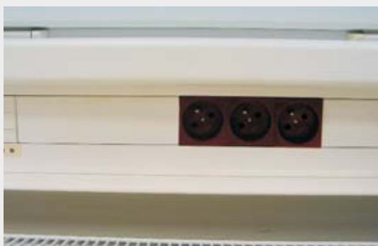
Příklad montáže parapetního kanálu PK 120X55 D.
