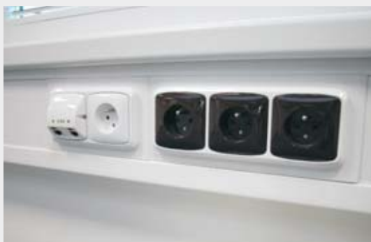
Příklad montáže parapetního kanálu PK 140X70 D.
