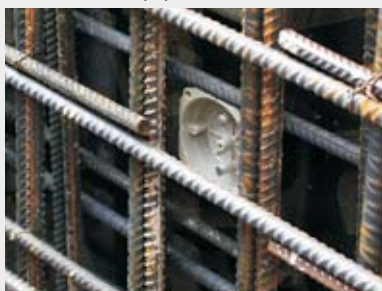
Víčko KBV připevněné na bednění.
