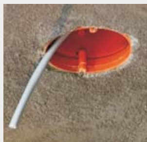
Krabice KBT... s vyvedeným vodičem připravená pro montáž lustrháku KBP...
