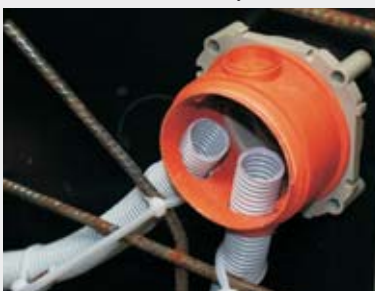
Namontované ohebné trubky do tělesa KBT.
