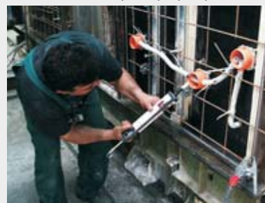
Utěsnění prostupů (tmel).
