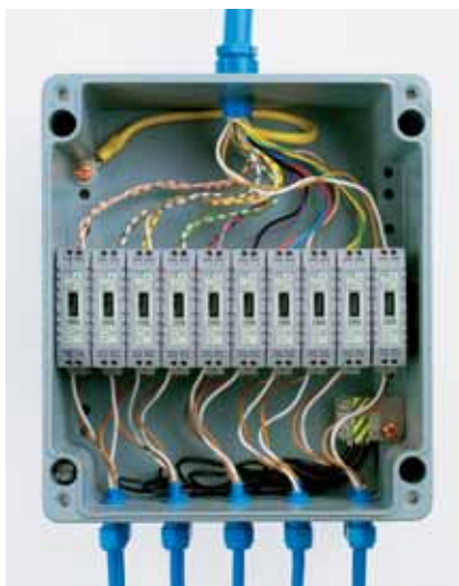
Obr. 2. „Intelligentní svorka“ v místě použití místo převodníku zvyšuje hustotu montáže.
