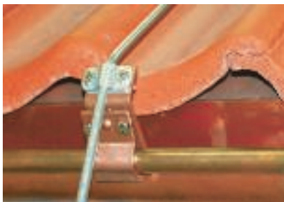
Správná instalace s bimetrickou svorkou (hliník/měď)
