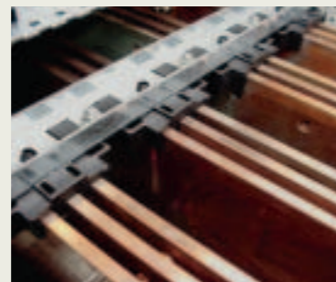
1 až 3 prípojnice na pól, hrúbka 10 mm
