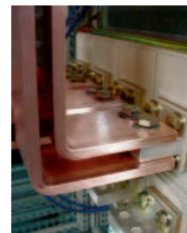
Pripojenie dvoch prípojnic 80x10 mm na každú svorku výsuvného vyhotovenia DMX 2 500.
