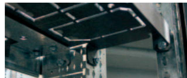
Montážne dosky pre DMX majú predvrtané otvory pre umožnenie vedenia lanka pre vzájomné blokovanie pri inverznom prepínaní napájania
