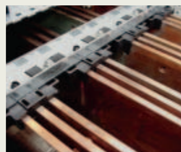
1 až 3 prípojnice na pól, hrúbka 10 mm
