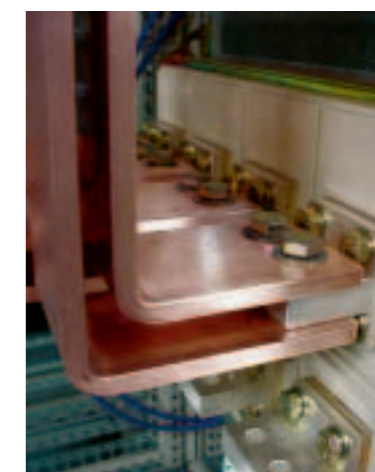
Pripojenie dvoch prípojnic 80x10 mm na každú svorku výsuvného vyhotovenia DMX 2 500.
