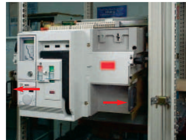
Výsuvné úchyty pre ľahké vysunutie prístroja.
