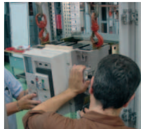
Montáž výsuvného vyhotovenia DMX
