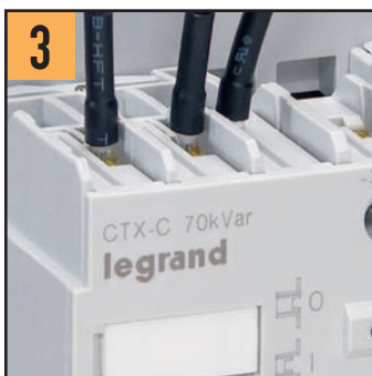
3 Obmedzovacie rezistory pre obmedzenie prúdového nárazu
